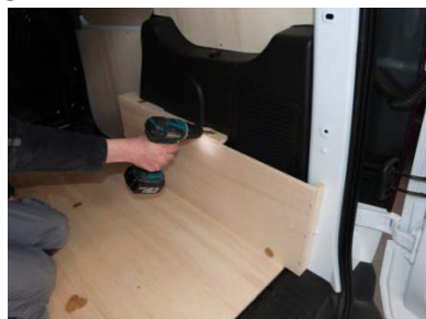
Placez et vissez le passage de roue Droit 4 vis 4x30
