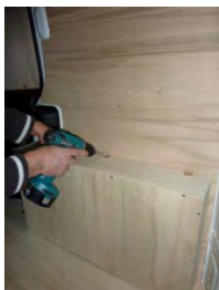
Placez et vissez le passage de roue Droit 7 vis 4x30
