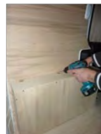
Placez et vissez le passage de roue Gauche 7 vis 4x30
