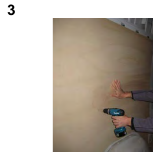
3 Placez & vissez le côté AR Gauche 14 vis 4x25
