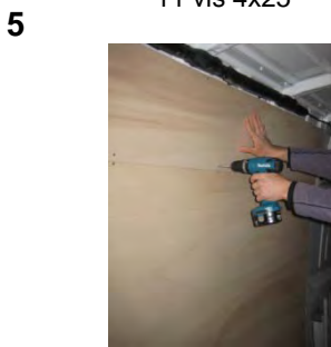
5 Placez & vissez les parties hautes Côté gauche 14 vis 4x25
