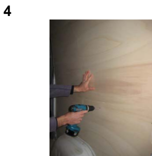
4 Placez et vissez le côté AR Droit 14 vis 4x25
