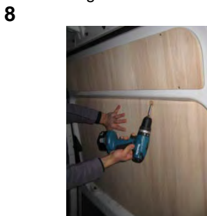
8 Placez & vissez la partie centrale De la porte latérale 4 vis 4x25
