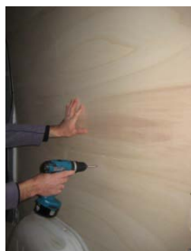
Placez et vissez le côté AR Droit 21 vis 4x25
