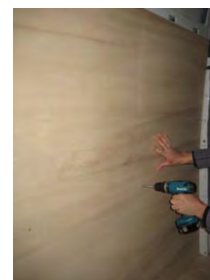
Placez & vissez le côté AV Gauche 11 vis 4x25
