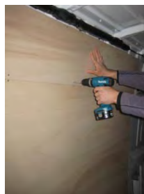
Placez & vissez les parties hautes Côté gauche 20 vis 4x25
