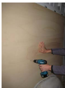
Placez & vissez le côté AR Gauche 21 vis 4x25
